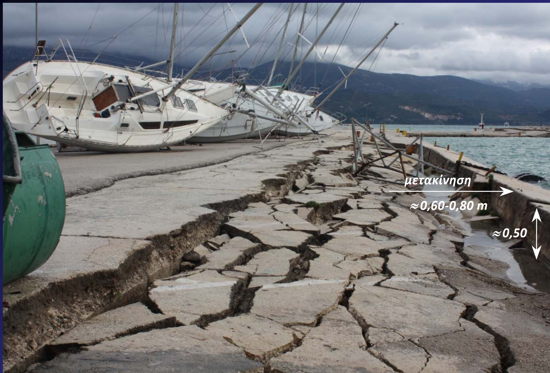
Μετακίνηση και στροφή κρηπιδοτοίχων
