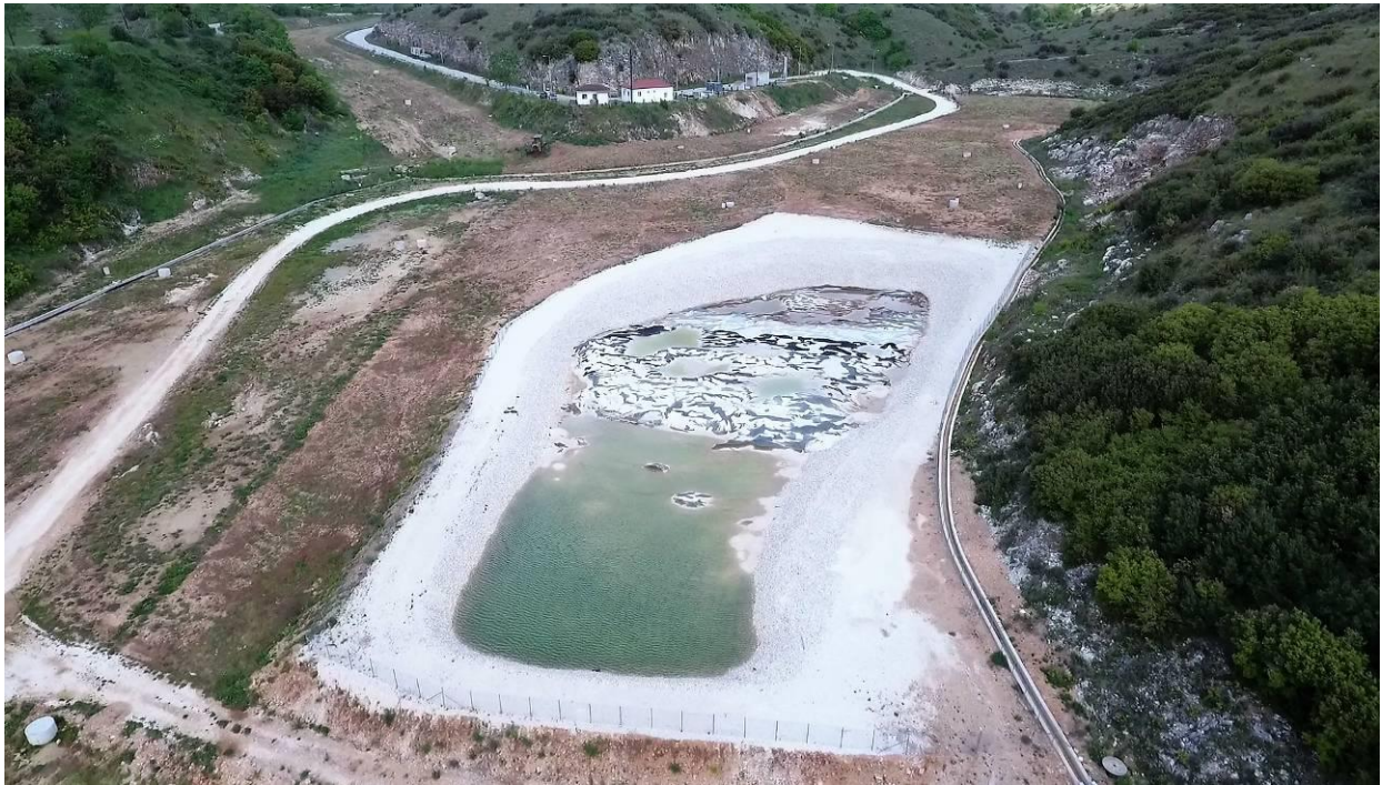
Φωτογραφία 4. Υλοποίηση της τεχνικής λύσης από την εταιρεία Μηχανική Περιβάλλοντος Α.Ε. Photograph 4. Implementation of the technical solution by Environmental Engineering S.A.
