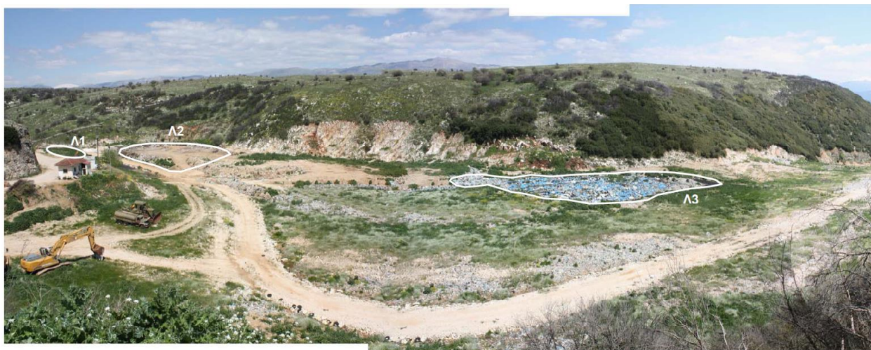
Φωτογραφία 1. Άποψη των λεκανών διάθεσης λιματολάσπης από ΝΔ (04/2013). Photograph 1. Sludge basins view from SW (04/2013).
