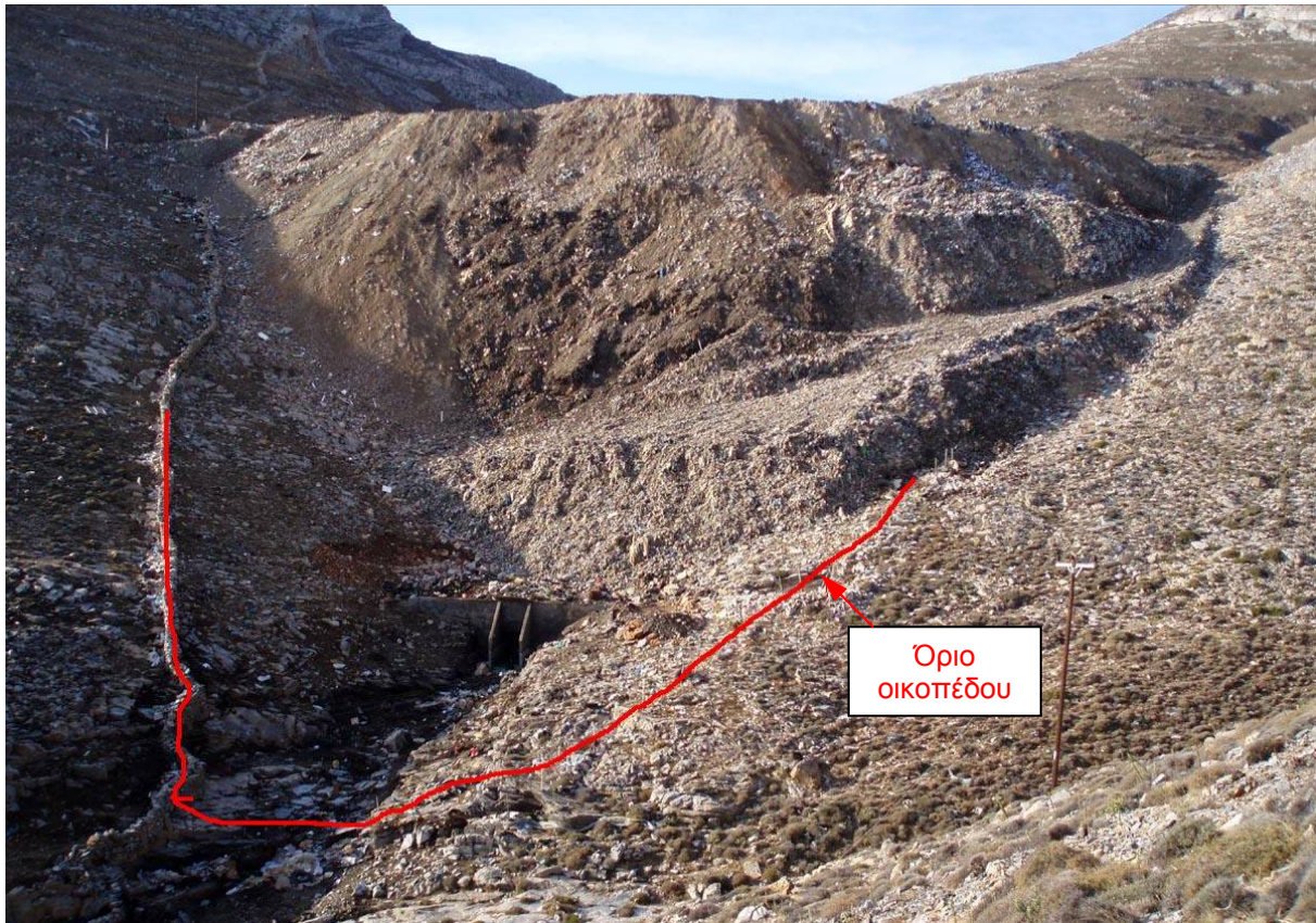
Φωτογραφία 1. Ο Χώρος του Χ.Α.Δ.Α. Σύρου πριν την Αποκατάσταση. Photograph 1. Syros Landfill Area before Final Closure.
