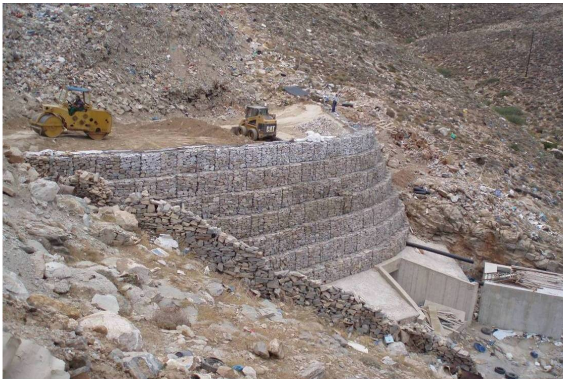
Φωτογραφία 2. Κατασκευή του Οπλισμένου Επιχώματος κατά τη Φάση των Εργασιών Αποκατάστασης. Photograph 2. Construction of Reinforced Earth during Landfill Final Closure.
